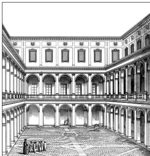
Paul M. Letarouilly, Collegio della Sapienza, in Edifices de Rome Moderne , 1860. Sede, ai tempi di Gismondi, dell'Archiginnasio La Sapienza, oggi Complesso di S. Ivo alla Sapienza, sede dell'Archivio di Stato.
