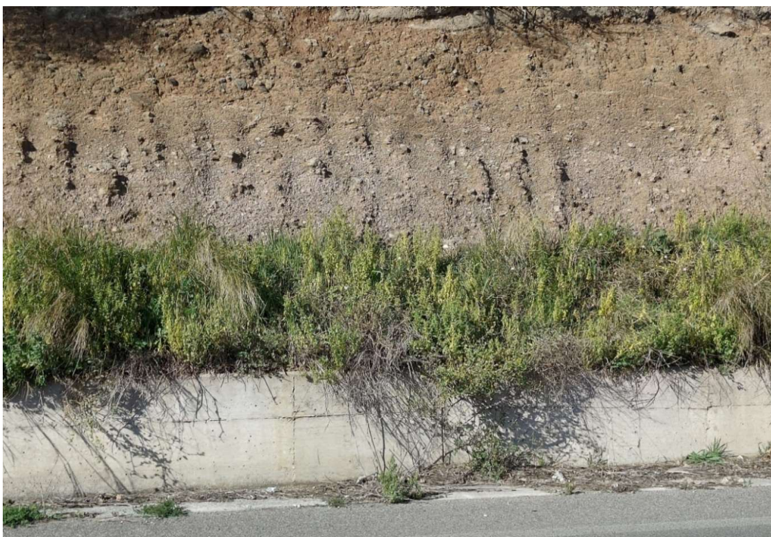
Fig. 6 – Sezione del deposito piroclastico (particolare).
