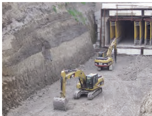
Lavori di escavazione dell'ultimo tratto della tangenziale dei castelli romani.
