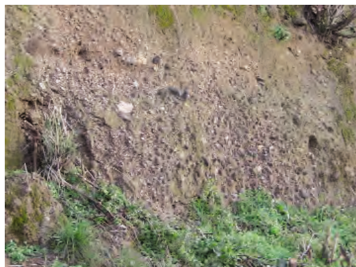
Parete con inclusi messa in evidenza dopo l'ultimo ampliamento della strada che rasenta Colle Cimino a Marino.
