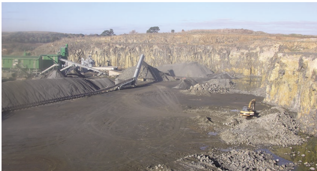
Fig. 1. Cava di Campomorto foto panoramica degli impianti.
