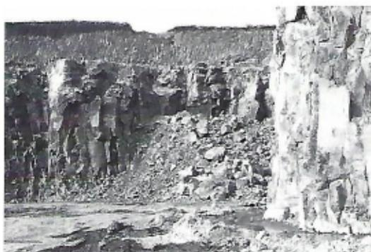
Foto 2: Particolare del fronte di scavo con gli enormi blocchi alla base della parete. Si possono notare sul fronte di scavo i giunti di raffreddamento della colata lavica.
